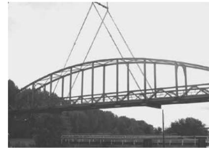
Sie besteht aus den zwei je 40 Meter langen Bögen der historischen „Wassertreppe 51“ und ersetzt den bisherigen baufälligen Holzsteg. Die Brücke ebnete einst den Weg zu einer Schiffswerft aus dem Jahre 1893 und gilt als eine der letzten erhaltenen dieser Art. Frisch saniert, entrostet und beschichtet verbinden die Bögen nun den Ponton mit dem Entenwerder Elbpark und der alten Zollanlage. Über die Brücke verlaufen künftig die Strom- und Wasseranschlüsse des „Goldenen Pavillons“.
